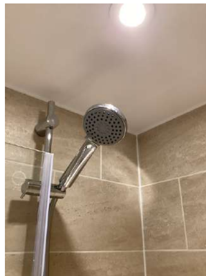
SALLE DE BAINS / DOUCHE
