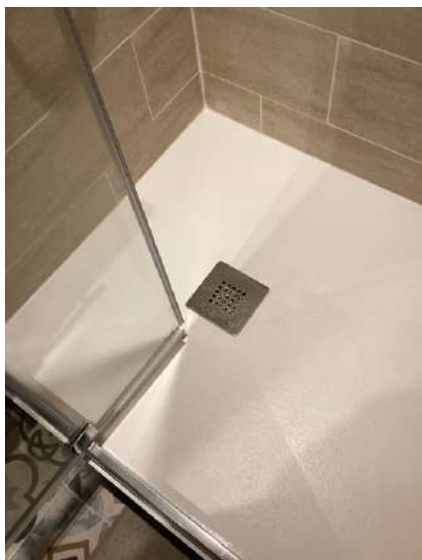
SALLE DE BAINS / DOUCHE
