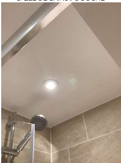
SALLE DE BAINS / DOUCHE
