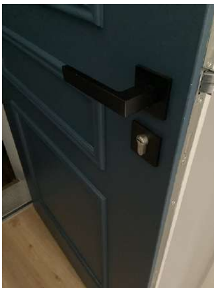
ENTRÉE / Porte d'entrée extérieure
