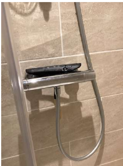
SALLE DE BAINS / DOUCHE
