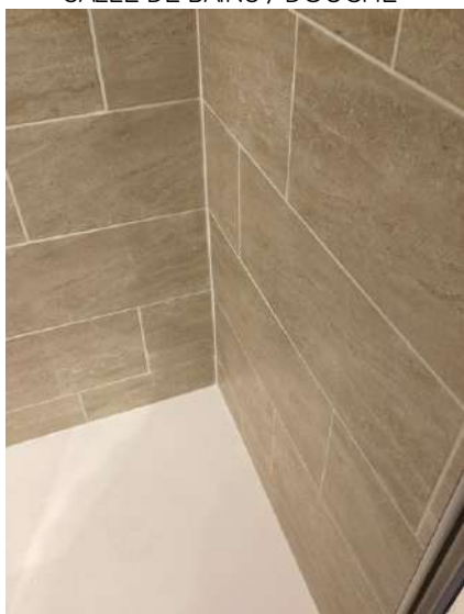
SALLE DE BAINS / DOUCHE
