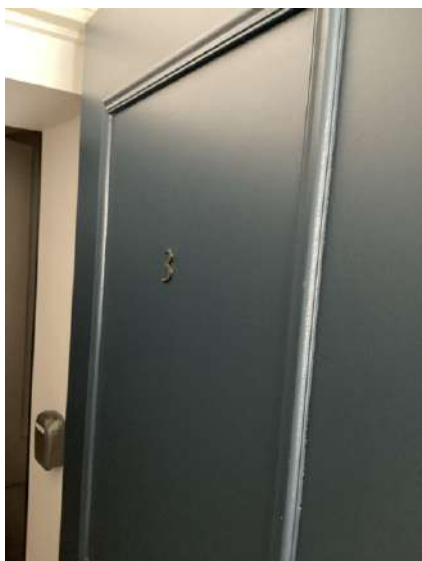
ENTRÉE / Porte d'entrée extérieure
