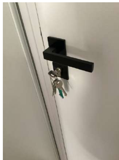
ENTRÉE / Porte d'entrée extérieure
