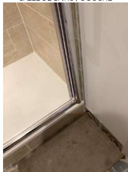
SALLE DE BAINS / DOUCHE
